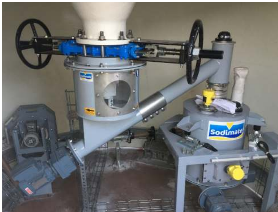
Sistema de dosificación gravimétrica
